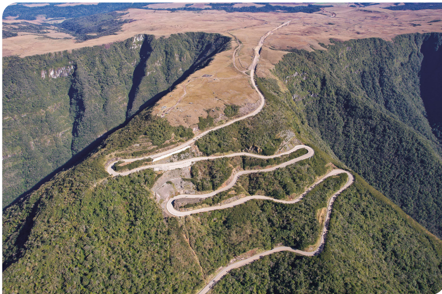
Serra da Rocinha: obra desafiadora para engenharia está localizada em área de sensibilidade ecológica
