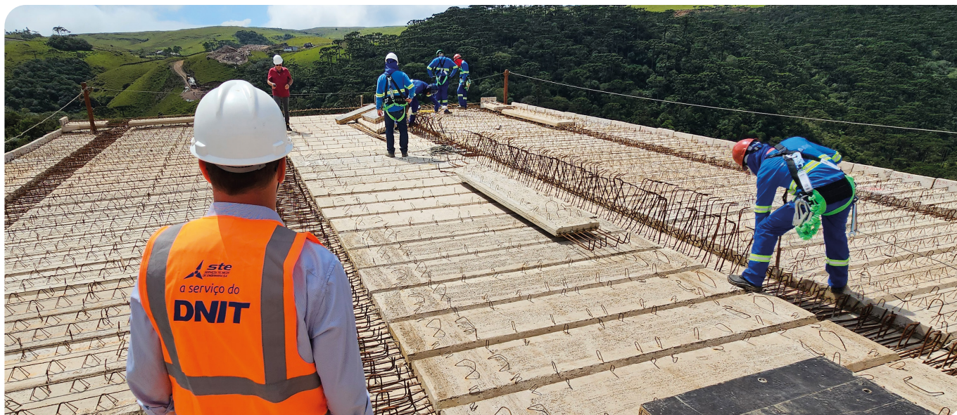
A construção da ponte sobre o rio das Antas é complexa e ocorre em área ambientalmente sensível, exigindo cuidados redobrados na prevenção de impactos
