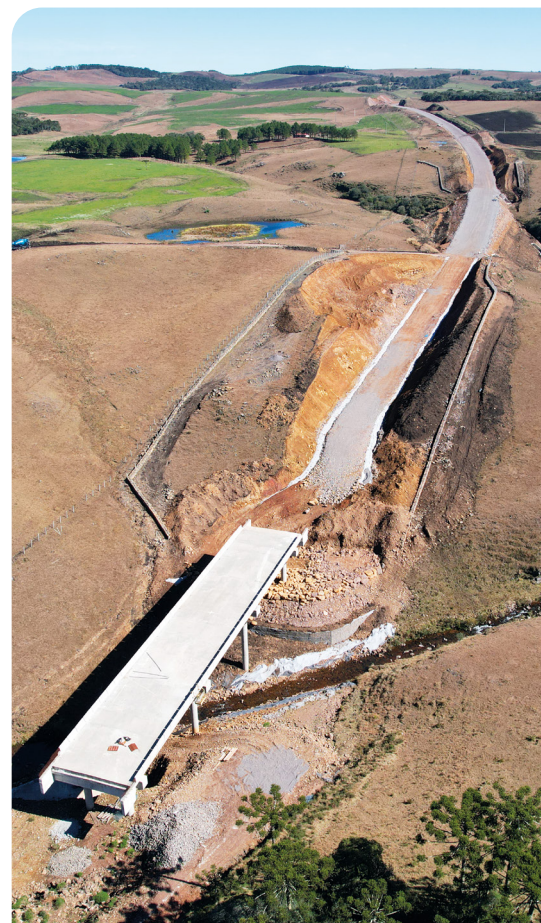
Trecho já conta com pontes concluídas e sub-base em 3,5 km
