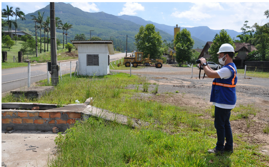
Equipe supervisiona o trabalho de desmobilização das estruturas e a destinação dos resíduos
