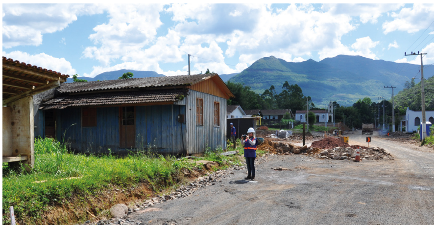
Vistorias apuram situações que possam comprometer a segurança de usuários e moradores lindeiros
