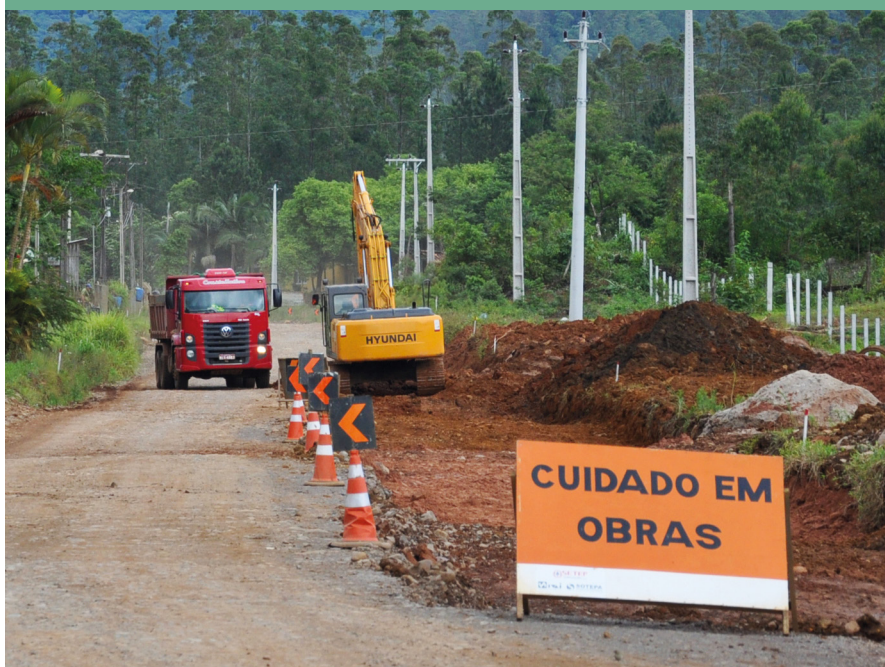
Obras de alargamento da pista e terraplenagem entre o final do asfalto existente e o pé da serra
