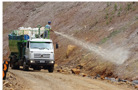
Hidrossemeadura é uma das técnicas utilizadas
