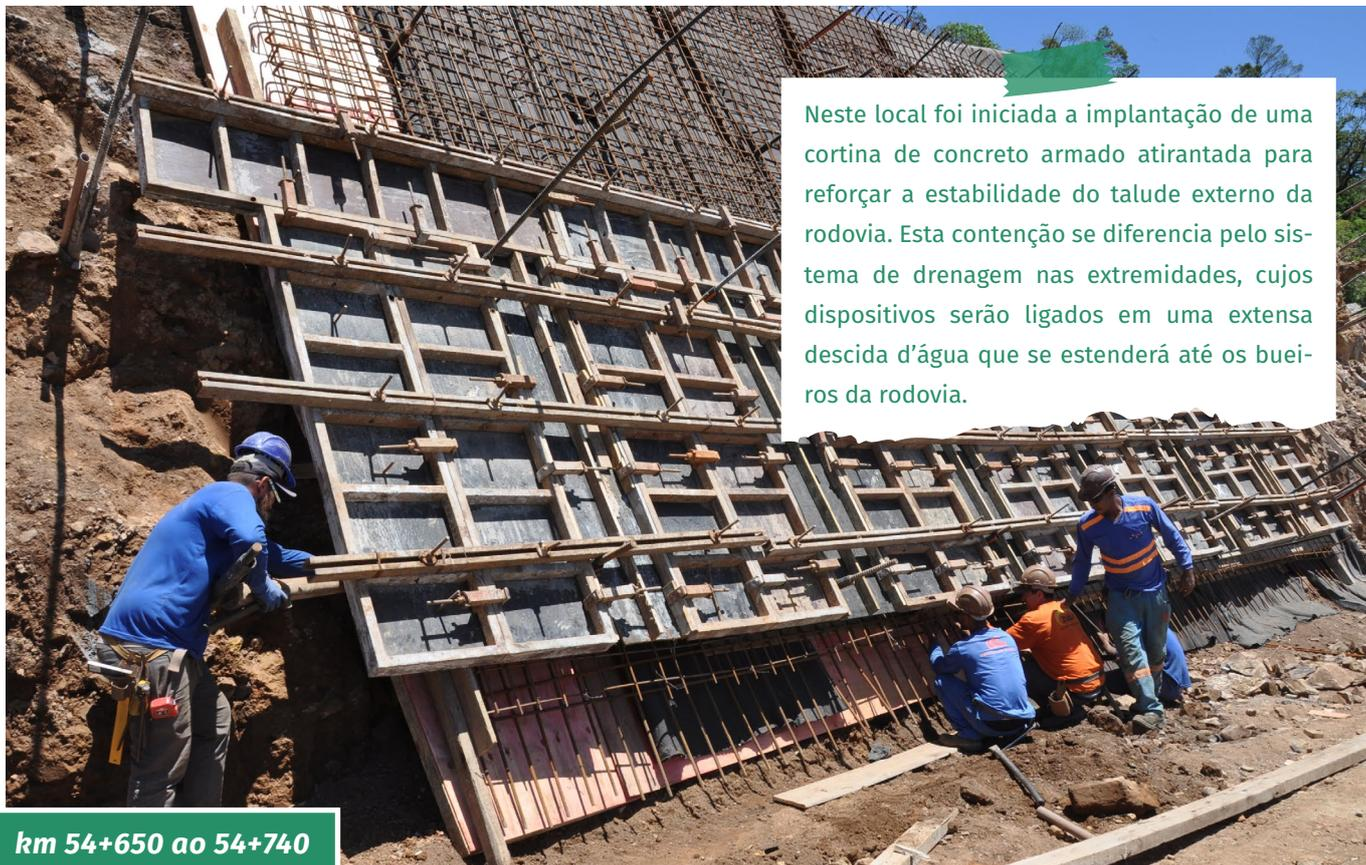
Neste local foi iniciada a implantação de uma cortina de concreto armado atirantada para reforçar a estabilidade do talude externo da rodovia. Esta contenção se diferencia pelo sistema de drenagem nas extremidades, cujos dispositivos serão ligados em uma extensa descida d'água que se estenderá até os bueiros da rodovia.
